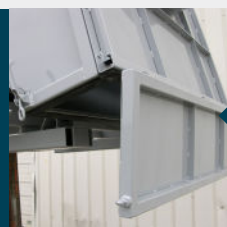
Volet étanche par joint mousse EPDM 40x10
