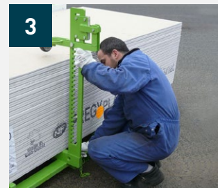
3 Pose des bras de retenue réglables
