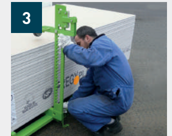
3 Pose des bras de retenue réglables
