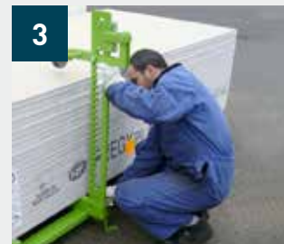
Pose des bras de retenue réglables
