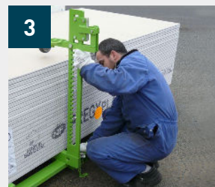
Pose des bras de retenue réglables
